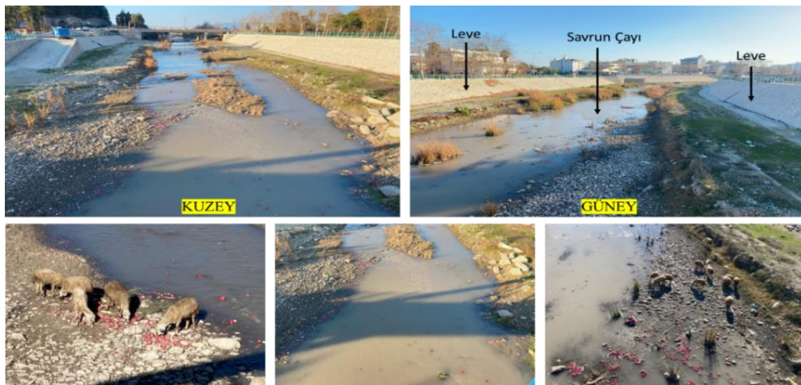
Fotoğraf 4. Yıkama ve İşleme Tesislerinin Güney Kısımında Kalan Savrun Çayından Görünüm (02.03.2022)
