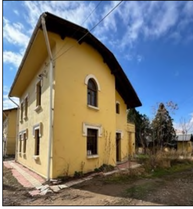
Şekil 18. Lojman I Kuzey Cephe.
