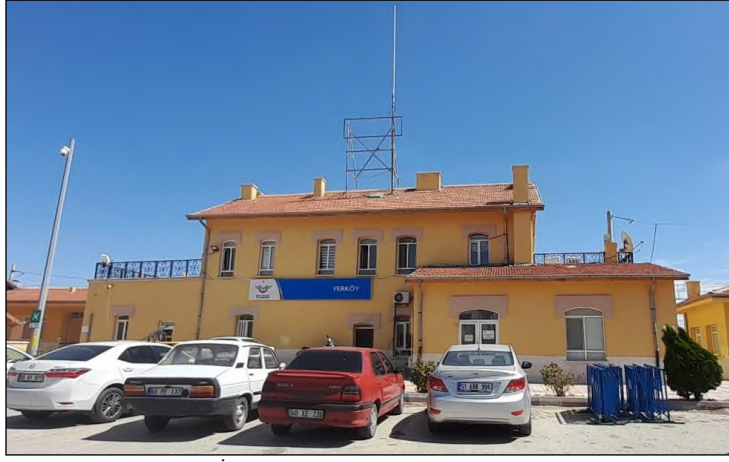
Şekil 14. Yerköy İstasyonu Yolcu Binası Batı Cephe, 2022.
