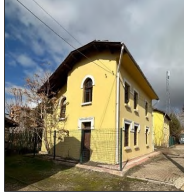
Şekil 17. Lojman I Güney Cephe.
