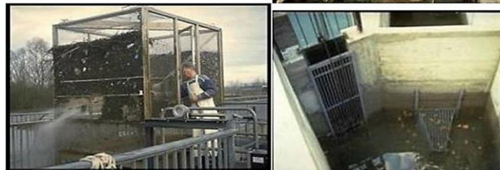
Şekil 3. Balık asansörüyle yapılan tuzaklama [29]’dan değiştirilmiştir
