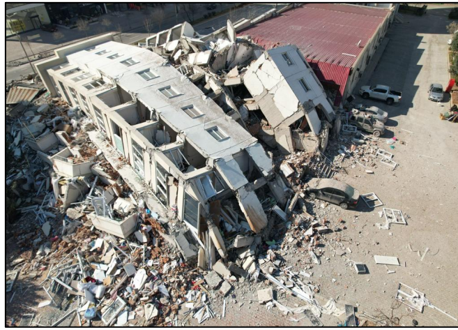
Şekil 5. Güçlendirme Yapılmadan İnşa Edilen Betonarme Yapıların, Yıkılan Bloklarının Enkaz Görüntüsü
