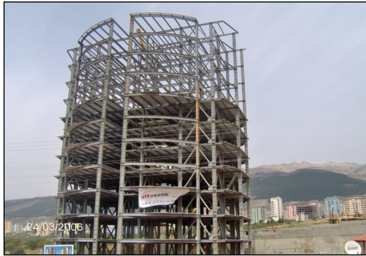
Şekil 2. Çelik Konstrüksiyon Yapının İnşa Aşamasındaki Bir Diğer Görüntüsü [2].
