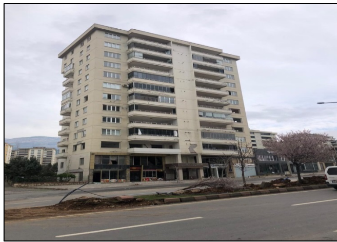
Şekil 6. Güçlendirme Yapılmadan İnşa Edilen Betonarme Yapıların, Ağır Hasar Alan Bloğunun Görüntüsü
