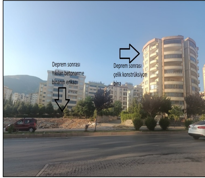
Şekil 4. Çelik Konstrüksiyon ve Betonarme Binaların Deprem Sonrası Görünümleri
