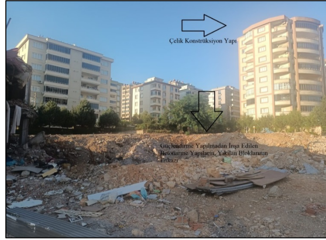
Şekil 7. Güçlendirme Yapılmadan İnşa Edilen Betonarme Yapıların, Yıkılan Bloklarının Enkaz Aşamasındaki Görüntüsü ve Çelik Konstrüksiyon Yapı
