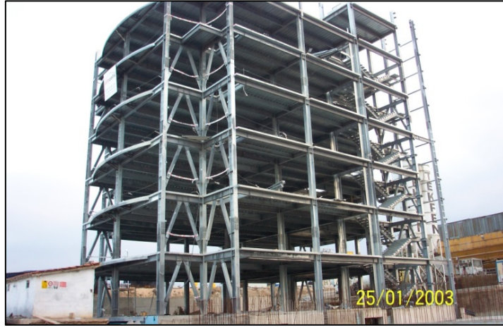
Şekil 1. Çelik Konstrüksiyon Yapının İnşa Aşamasındaki Görüntüsü [2].
