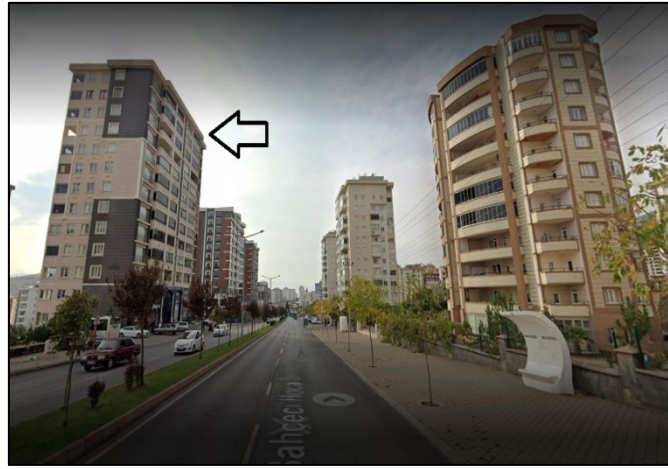
Şekil 8. Zemin İyileştirme Çalışması Yapıldıktan Sonra İnşa Edilen Betonarme Karkas Yapı ( https://www.google.com/streetview/ )
