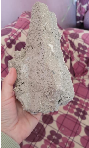
Şekil 15: Kalın sıva uygulaması.
