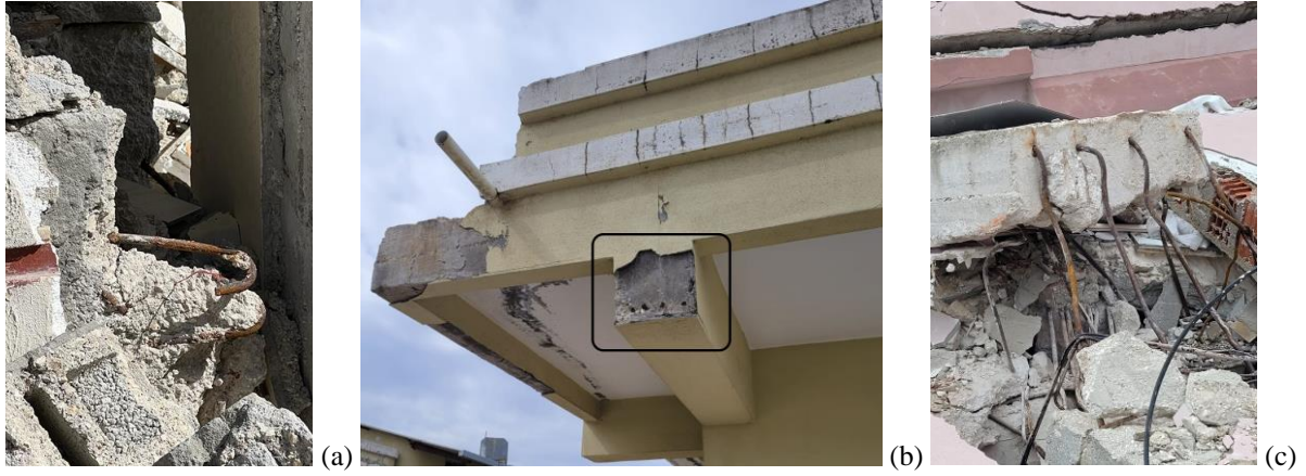
Şekil 7: Hatalı donatı uygulamaları.
