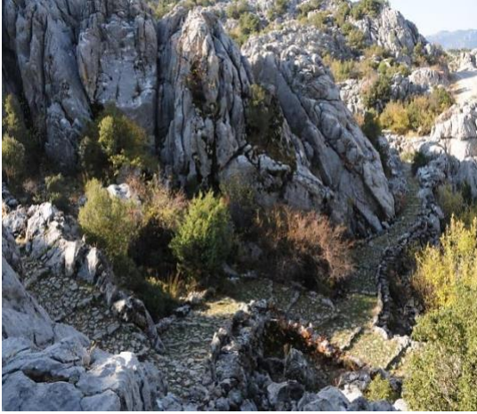
Şekil 6. Sadıklar-Güzelsu Arası Osmanlı Yolu (Adak, 2016)
