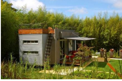
Şekil 8. Konteynerlerde çatı, (URL2, 2014).
