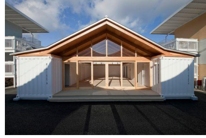
Şekil 9. Konteynerlerde çatı, (URL3, 2012).
