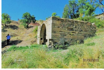
Şekil 16: Güneydoğu dış cephe
