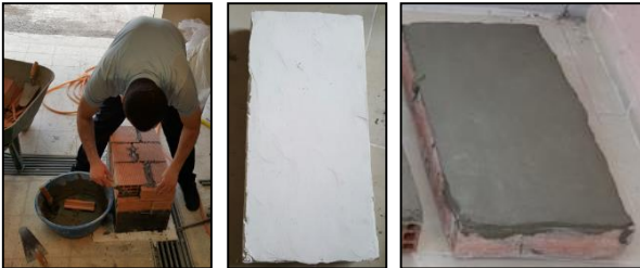
Şekil 3: Duvar İmalatı ve Sıva Uygulaması (Kaya, 2016)
