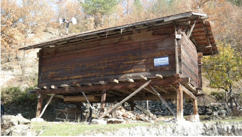
Resim 15: Susuz Köyü Merkez Camii'nin Batı Cephesi.
