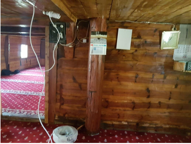
Resim 12: Çorakdere Köyü Corukdere Mahallesi Camii Minaresinin Mili.
