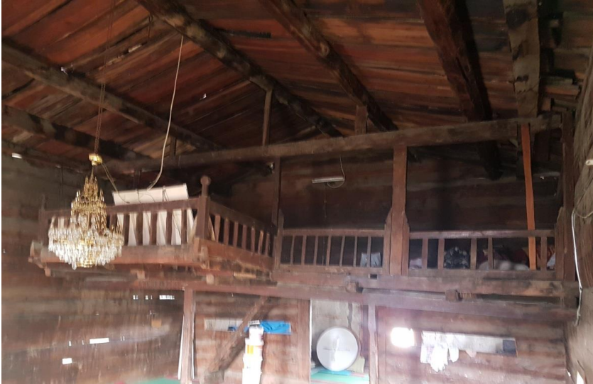
Resim 6: Karanar Köyü Camii'nin Mahfil ve Çatısından Görünüm.
