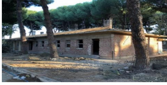
Şekil 17: Kreşin Giriş Bölümünün Eski Görünüşü, Etm Mimarlık, 2021
