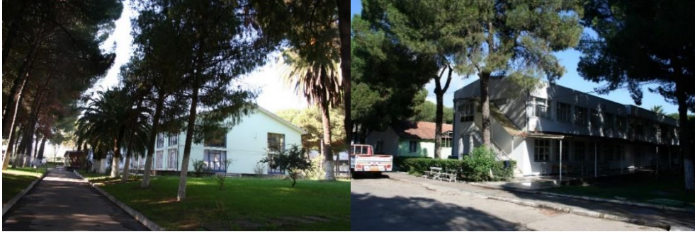
Şekil 22: Restorasyon Öncesi Yemekhaneye Ait Fotoğraflar, Aydın Büyükşehir Belediyesi, Kent Tarihi ve Tanıtımı Daire Başkanlığı
