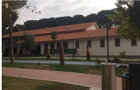
Şekil 27: Holly Stone Performance Hall'un 2022 Yılındaki Görünüşü, Kişisel Arşiv, 2022
