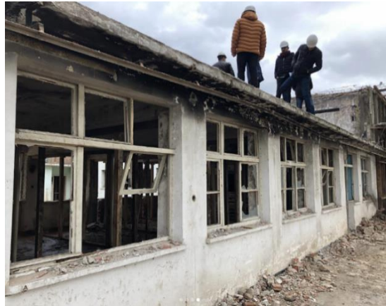
Şekil 4: Yanan Yapının Restorasyon için Saha Taraması, Etm Mimarlık, 2022
