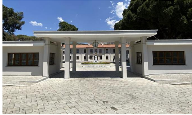
Şekil 8: 2022 Yılındaki Ana Girişten Görünüm, Etm Mimarlık, 2022
