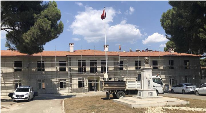
Şekil 11: 2019 Yılında Restorasyon Sırasında Aydın Tekstil Fabrikası Yerleşkesi İdari Binası, Kişisel Arşiv, 2019
