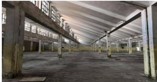
Şekil 34: Üretim Yapısının Çatı ve Pencerelerinin Detayı, Etm Mimarlık, 2021
