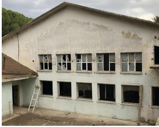
Şekil 3: Yanan Yapının Restorasyon için Saha Taraması, Etm Mimarlık, 2022
