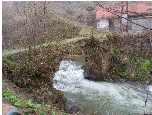
Foto. 41. Goballı Köprüsü Malzeme Detayı (2024)
