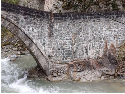
Foto. 19. Kaşıkçı Köprüsü Ayak Detayı (2024)
