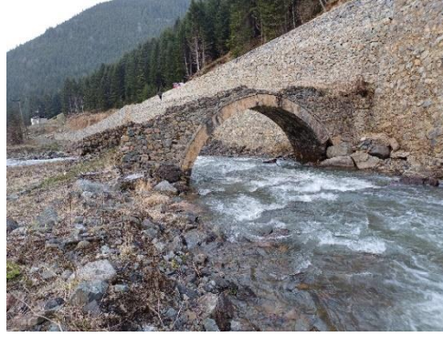
Foto. 48. Binatlı (Terzili, Cingalli) Köprüsü Güney Cephe Görünüm (2024)
