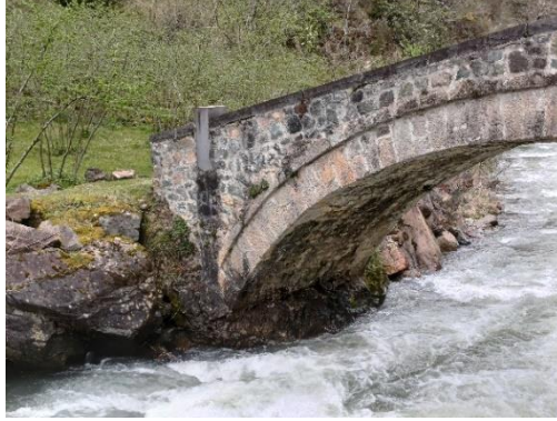
Foto. 12. Sincan Köprüsü Malzeme Detayı (2024)
