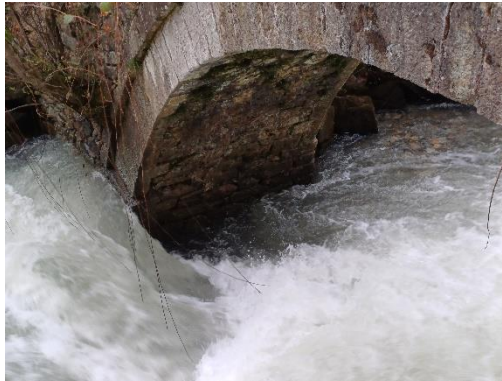
Foto. 35. Agrit Köprüsü Ayak Detayı (2024)
