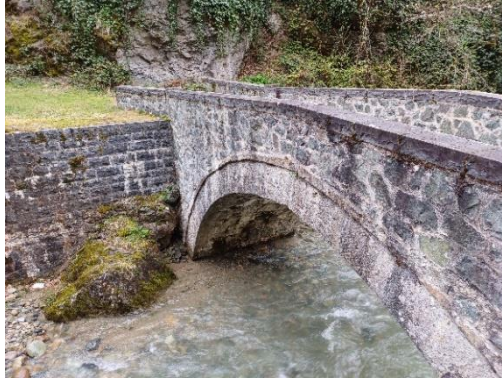
Foto. 24. Tandırlı Köprüsü Malzeme Detayı (2024)
