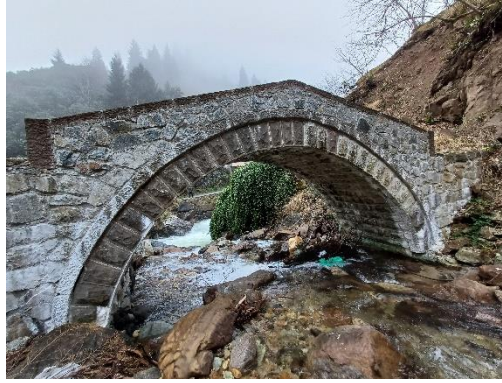
Foto. 29. Tarihi Agrid (Çamlıyurt II) Köprüsü Malzeme Detayı (2024)
