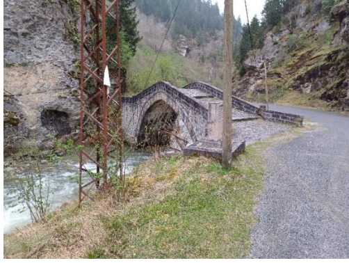
Foto. 16. Kaşıkçı Köprüsü Güney Cephe Görünüm (2024)
