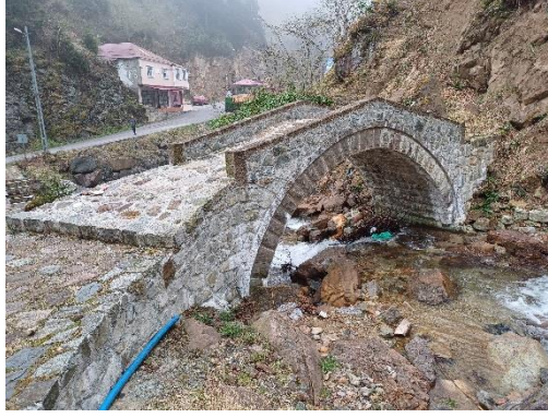
Foto. 28. Tarihi Agrid (Çamlıyurt II) Köprüsü Kemer Detayı (2024)
