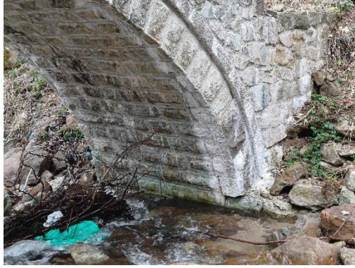
Foto. 30. Tarihi Agrid (Çamlıyurt II) Köprüsü Ayak Detayı (2024)
