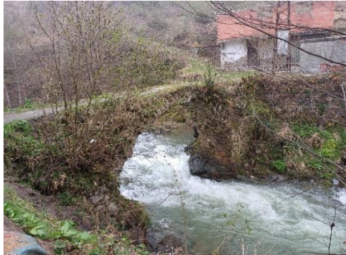
Foto. 38. Goballı Köprüsü Kuzey Cephe Görünüm (2024)
