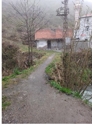
Foto. 40. Goballı Köprüsü Tabliye Görünüm (Y. Sarı, 2024)
