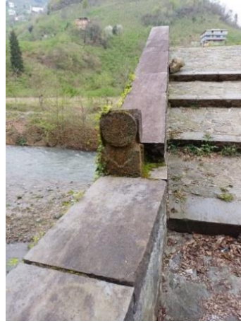
Foto. 4. Yeniköy Köprüsü Baba Taşı Örneği (2024)
