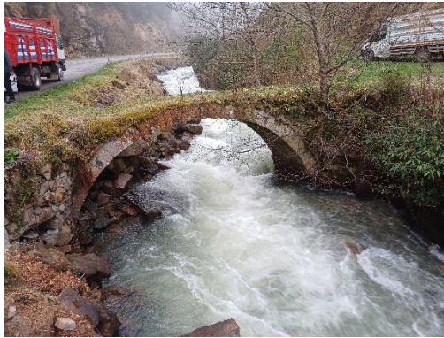
Foto. 32. Agrid Köprüsü Kuzey Cephe Görünüm (2024)
