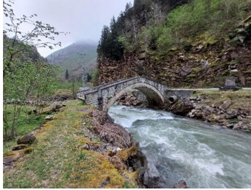
Foto. 9. Sincan Köprüsü Kuzey Cephe Görünüm (2024)
