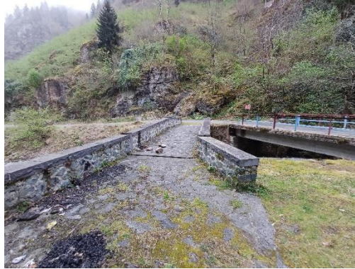
Foto. 23. Tandırlı Köprüsü Tabliye Görünüm (2024)
