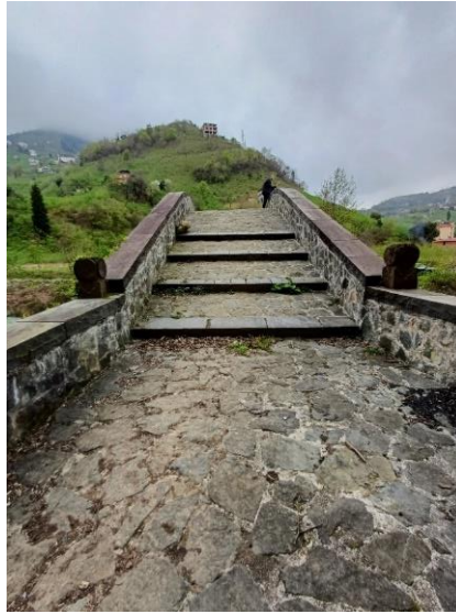
Foto. 5. Yeniköy Köprüsü Tabliye Görünüm (2024)
