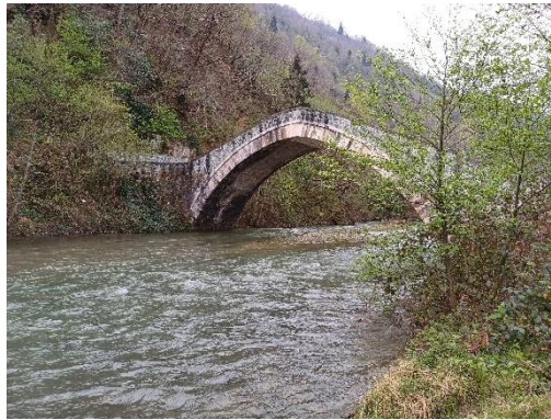
Foto. 3. Yeniköy Köprüsü Kuzey Cephe Görünüm (2024)
