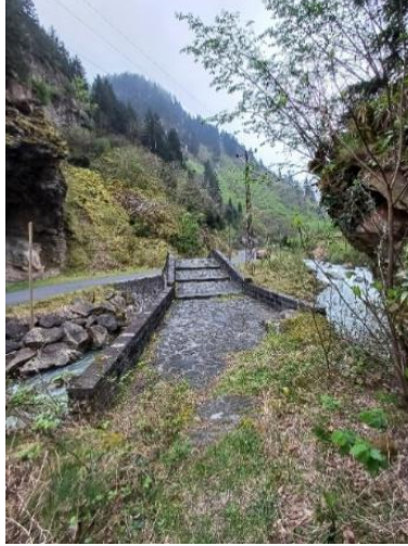
Foto. 17. Kaşıkçı Köprüsü Tabliye Görünüm (2024)
