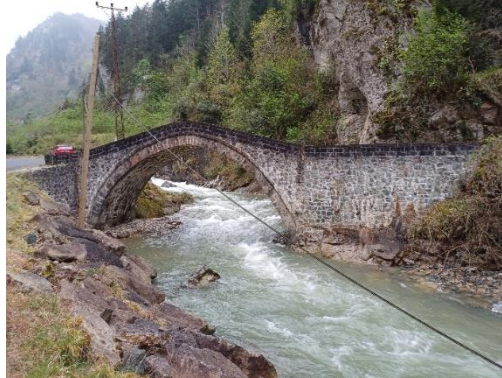
Foto. 15. Kaşıkçı Köprüsü Kuzey Cephe Görünüm (2024)
