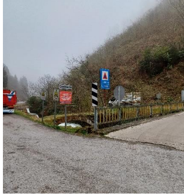
Foto. 36. Agrid Köprüsü Yanı Yeni Köprü (2024)
