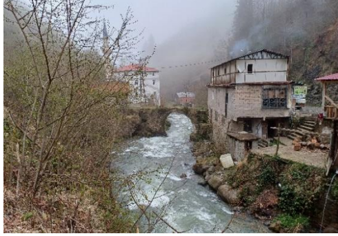
Foto. 42. Goballı Köprüsü Yanı Ticarethane Yapısı (2024)
