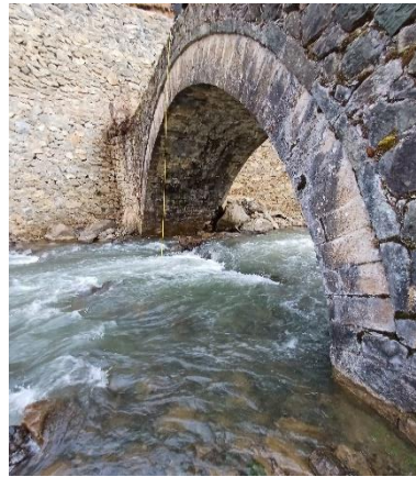
Foto. 50. Binatlı (Terzili, Cingalli) Köprüsü Ayak Detayı (2024)
