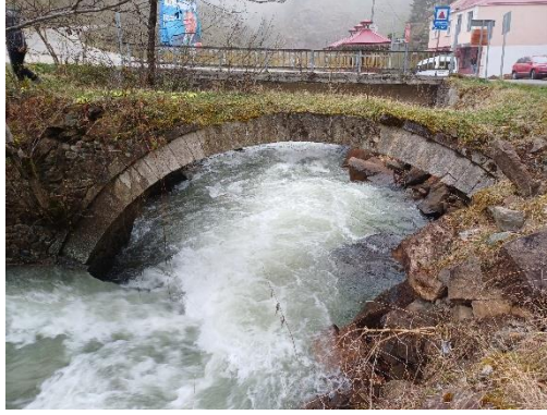
Foto. 33. Agrit Köprüsü Güney Cephe Görünüm (2024)
