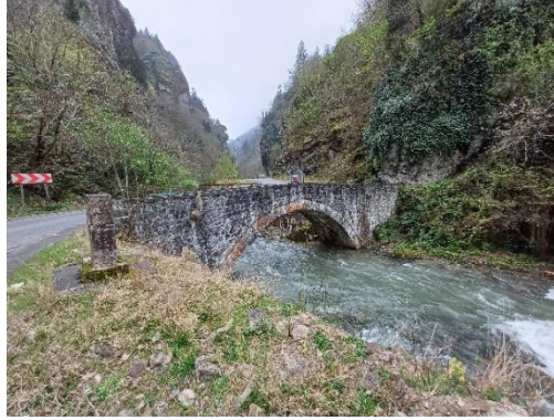
Foto. 22. Tandırlı Köprüsü Kuzey Cephe Görünüm (2024)
