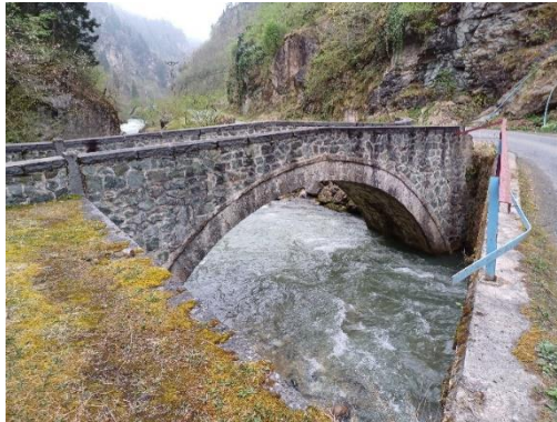
Foto. 21. Tandırlı Köprüsü Güney Cephe Görünüm (2024)
