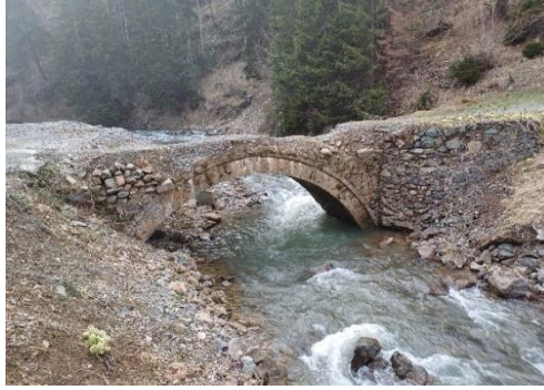
Foto. 43. Yamakoğun (Ayeni) Köprüsü Kuzey Cephe Görünüm (2024)
