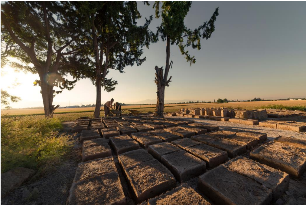
Fig. 13: Kalıplara dökülen ve kurutulan 40 x 40 x 12 cm boyutundaki kerpiçler (Fotoğraf M. Akar).
