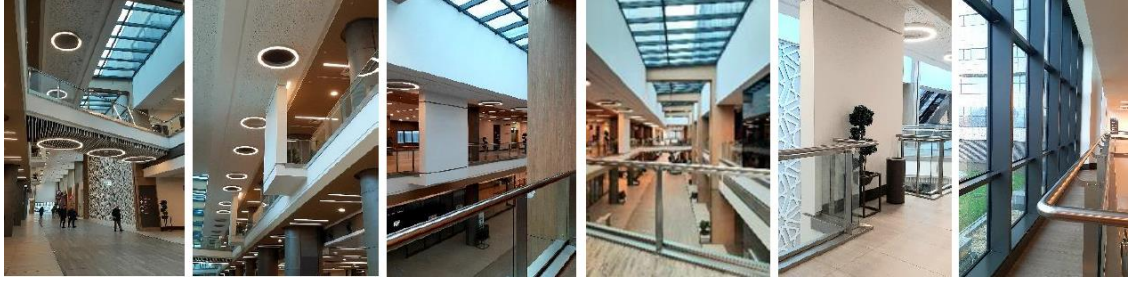
Şekil 15. Risk fotoğrafları, Başakşehir Çam ve Sakura Şehir Hastanesi
