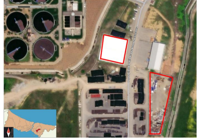
Şekil 2. Paşaköy Atık Geçici Depolama Alanı (kırmızıyla çevrili) uydu görüntüsü (beyaz bölge tehlikeli atık, diğer bölge tehlikesiz atık depolama alanına göstermektedir).
