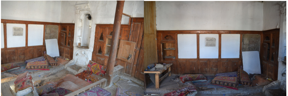
Foto 12: Oda Genel Görünüş
