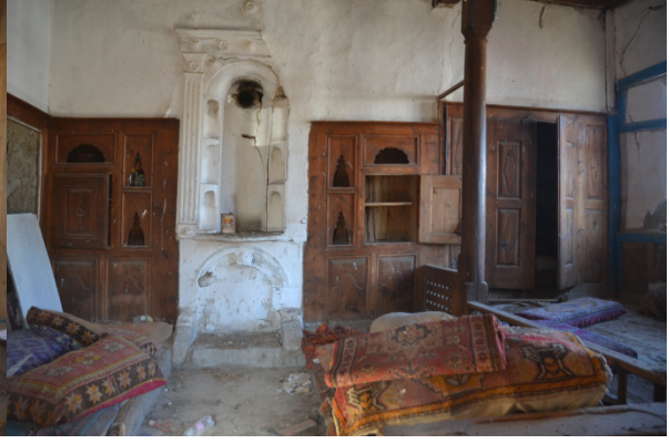
Foto 15: Oda Mekânı Doğu Cephe
