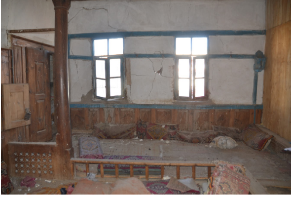
Foto 14: Güney Cephe Mumseki'Nimseki
