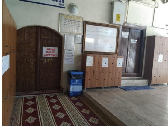
Foto 4. Kuzey Cephe Pencerenin Kapı Olarak Açılması
