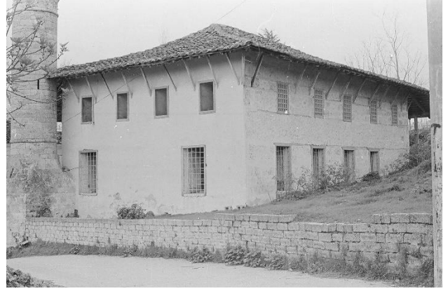
Foto 2. Şeyh Sinan Camisi'nin Güney-Doğu Cehesi (VGM Arşivi)
