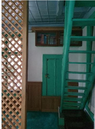
Foto 21. Mahfile Çıkan Merdiven Merdiveni (Mimar Özlem Durmaz Kaya)
