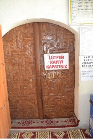
Foto 5. Kuzey Cephe Ana Giriş Kapısı (Mimar Özlem Durmaz Kaya)
