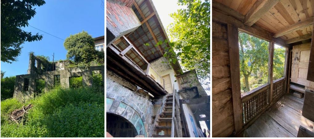
Şekil 3. Araştırma Alanında Bulunan Restorasyona Uygun Bazı Yapılar
