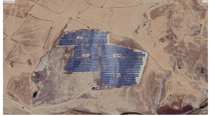
Fotoğraf 9. Subaşı Mahallesi kuzeyindeki, çevreden tortul taşınmasını ve damla erozyonunu engelleyen GES (Kaynak: Google Earth)
