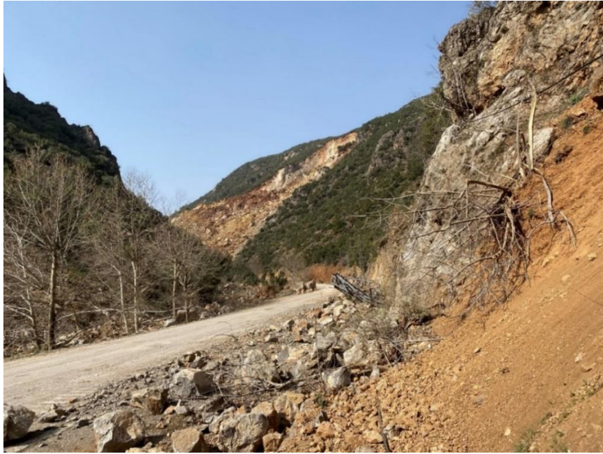
Şekil 16. Heyelanın Değirmencik vadisini kapatması, mansaptan bakış Figure 16. Landslide closing the Değirmencik valley, view from downstream
