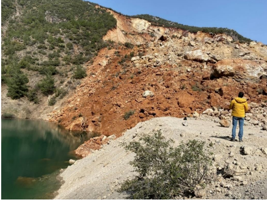
Şekil 15. Heyelanın kopma yüzeyi, mansaptan bakış Figure 15. Landslide rupture surface, downstream view
