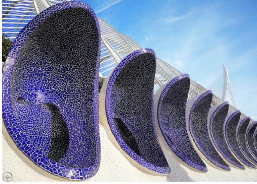
Mozaik Karo Kullanımı- Calatrava
