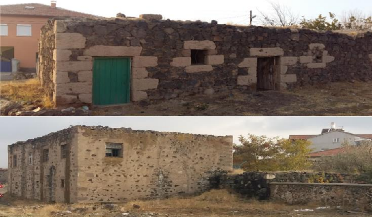
Fotoğraf 2: Karacaören Köyü, Bazalt Yapı Malzemeli Eski Konutlar
