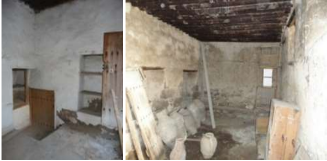
Şekil 9. Solda 106 mekânı ve zemin kata geçiş kapısı, sağda ahır veya depo olduğu düşünülen 107 mekânı
