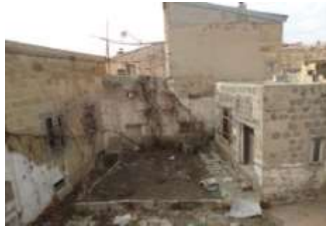
Şekil 19. İç avlu kuzey cephesi (Avlu duvarı ve müştemilatın kuzey cephesi)
