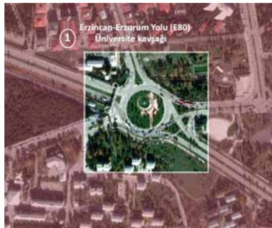
Şekil 9. Erzincan-Erzurum yolu (E80), Üniversite Kavşağı.
