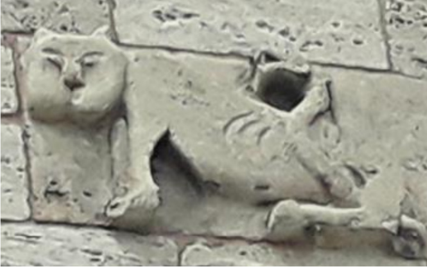
G. 17: Sivas Behram Paşa Hanı (Oral, “Tarihi Han Yapılarının Yeniden İşlevlendirilmesi ve Behram Paşa Hanı Örneği Özelinde İç Mekanlarının İrdelenmesi,” 45)
