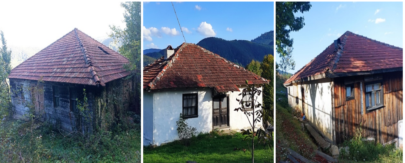
Görsel 23. Derdin köyü kırma çatı örnekleri
