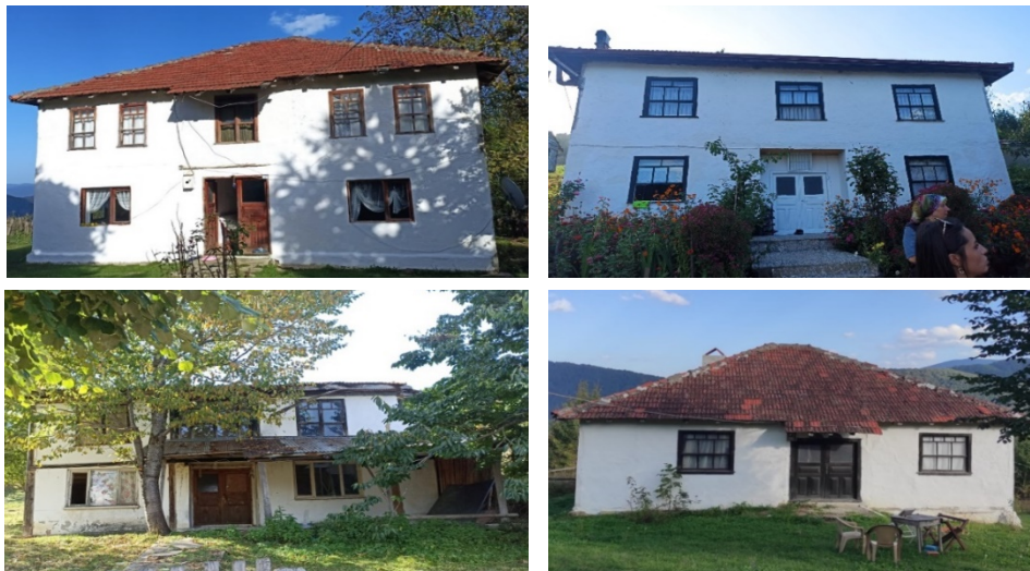
Görsel 13. Derdin köyü giriş cephe düzeni
