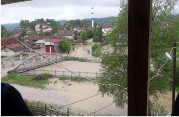
Foto 1. Tatlıcak Mahallesi'ndeki Gürnapınar Deresi Taşkını
