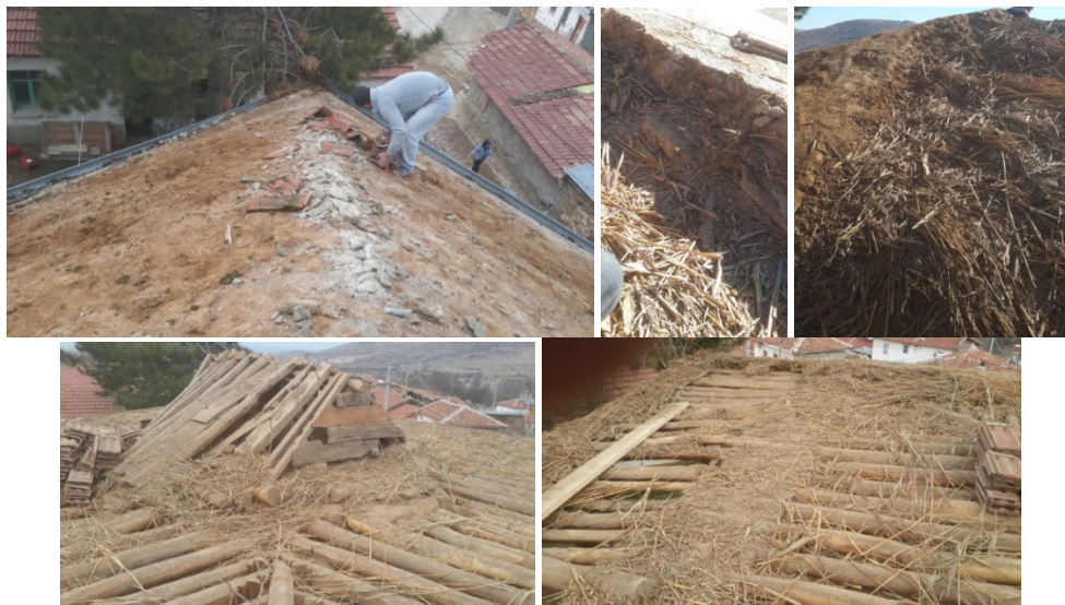
Şekil 2. Cami toprak dam detayını gösterir fotoğraflar (Kaynak: Yazarlara ait fotoğraf arşivi, 2016).
