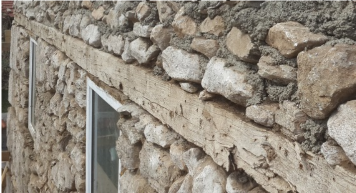
Şekil 15. Cami beden duvarlarında arkası boşalan özgün taşların yeniden harçlanarak yerine yerleştirilmesini gösterir fotoğraf (Kaynak: Yazarlara ait fotoğraf arşivi, 2016).
