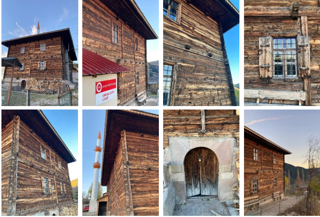
Şekil 4. Çoraklı Köyü Camisi'nin cephe görüntüleri Figure 4. Facade views of Çoraklı village mosque
