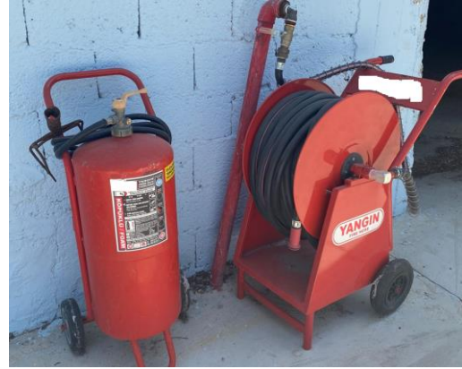
Şekil 8. Köpüklü söndürme cihazı ve Arabalı yangın hortumu
