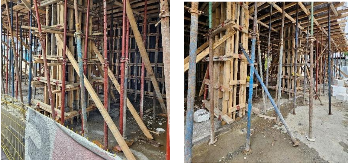
Şekil 4: Destek payanda (ahşap/metal) (Yazar tarafından üretilmiştir, 2024)
