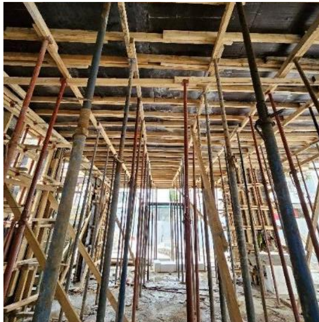
Şekil 3: Döşeme kalıp görseli (Yazar tarafından üretilmiştir, 2024)
