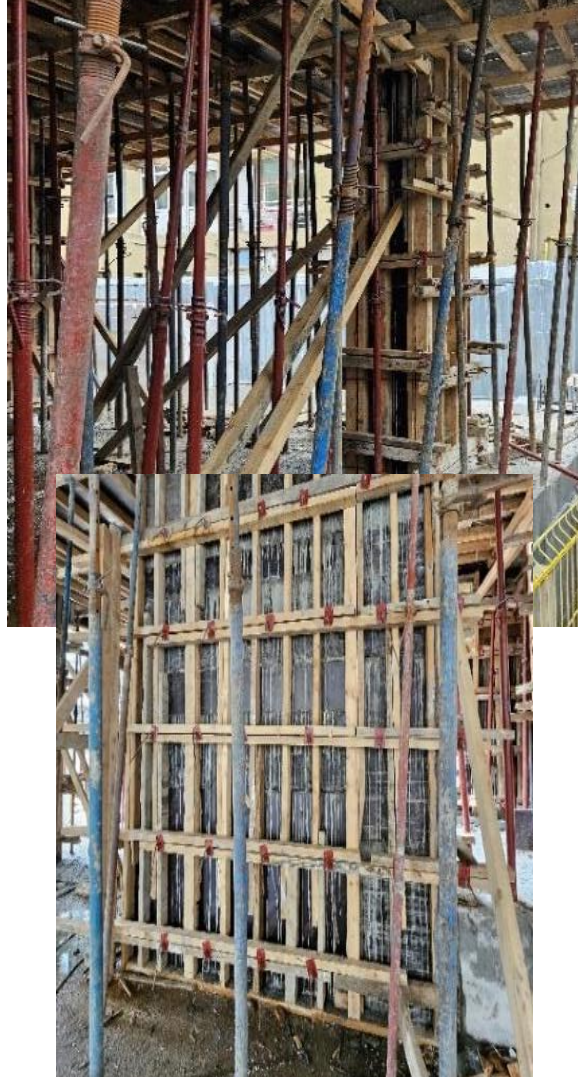
Şekil 2: Kolon kalıp görseli ve perde kalıp görseli (Yazar tarafından üretilmiştir, 2024)
