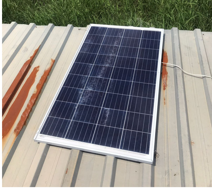
Şekil 2. 12V, 130 W, 32 hücreli polikristal yapılı güneş paneli (12V, 130 W, 32-cell polycrystalline solar panel)
