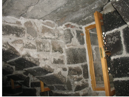
Şekil.10. Bodrumun üst döşemede sal taşının kullanımı
