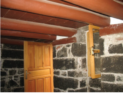
Şekil 11. Ahşap kirişli döşeme
