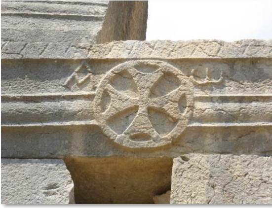
Res. 5: Apsis İç Duvarındaki Malta Haçı
