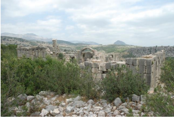
Res. 7: Akören Kuzey Kilise Batı Cepheden Genel Görünüm
