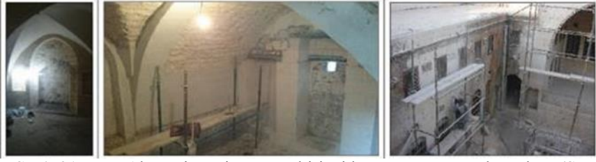
Şekil.31. Hacı Abo Evi zemin, ara ve birinci kat restorasyon çalışmaları, (S. Açıanal Arşivi,2014)
