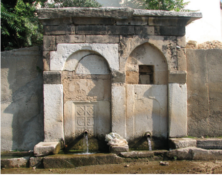
Fot. 7: Aktaş Köyü Aşağı Çeşme.
