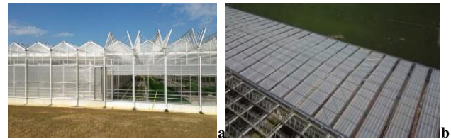
Şekil 1. Dik çatılı (a) ve mobil çatılı (b) sera sistemleri [5, 6]
