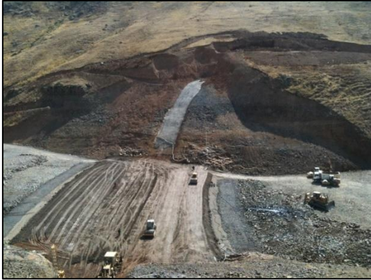
Şekil 3. Morgedik barajının kil çekirdek yapım aşamasından bir görünüm.
