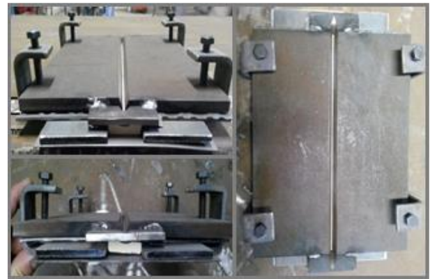
Şekil 1. Kaynak öncesi parçaların sabitlenmesi (Fixing the pieces before welding).
