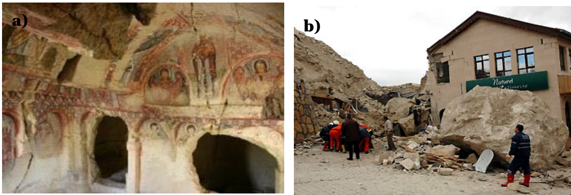
Şekil 2. a) Göreme AHM. Meryem Ana Kilisesi'ndeki yapısal çatlaklar (Bilgili Kişisel Arşivi). b) Ürgüp Temenni Tepesi, 2007 yılı kaya düşme vakası (URL: www.mynet.com/haber/yasam/urgupte-diskoya-kaya-dustu-3-olu-275903-1 ET: 11.03.2013 )
