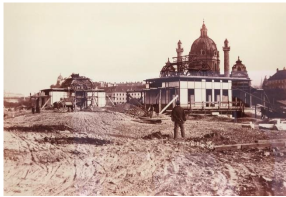
Şekil 27 Karlsplatz istasyonu inşası
