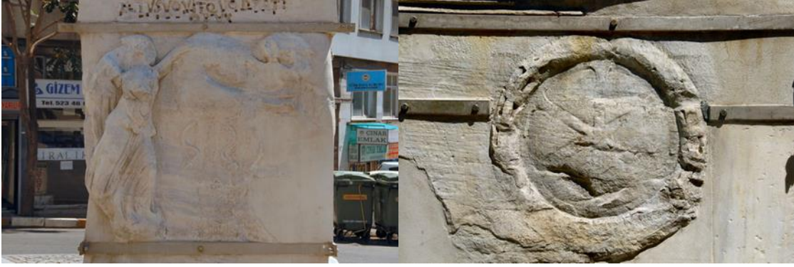
Şekil 24 Markianos Sütunu kaidesinin kuzey ve batı cephelerinden fotoğrafı
