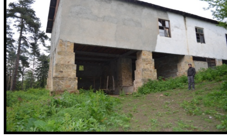
Şekil 42: Çangal istasyonunda bulunan havai hat iptal edilince istasyonun yükleme bölümündeki ayaklar üzerine inşa edilen bina uzun yıllar bölgede çalışanlara sinema olarak hizmet etmiştir. Günümüzde atıl durumdadır.
