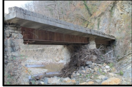
Şekil 24-25: Zindan hattında demiryolu raylarının üzerine kurulmuş bir köprü. Sadece Zindan hattında bu şekilde kurulmuş 6 köprü bulunmaktadır.
