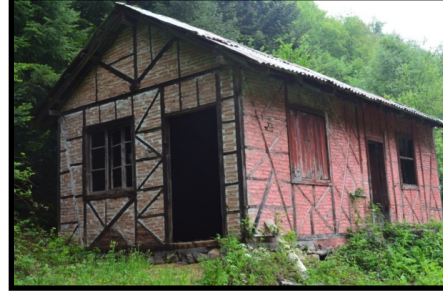
Şekil 65: Yemişli jeneratör binası.
