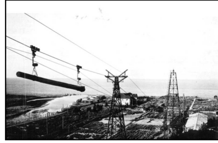
Şekil 23: Havai hat ile fabrikaya ulaşan tomruklar.
