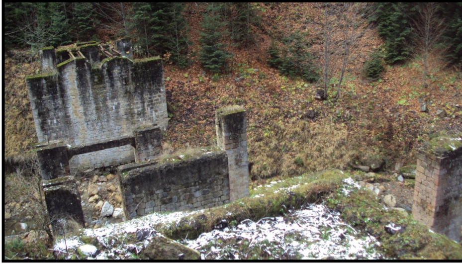
Şekil 57: Çukurçay istasyonu temel beton kalıntıları.
