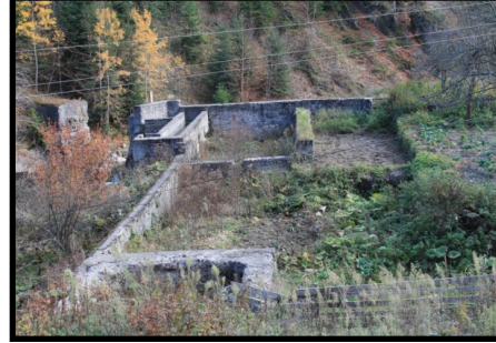
Şekil 63: Yemişli istasyonunda bulunan tomruk havuzu kalıntıları.
