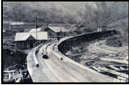
Şekil 18: Barajlarda biriktirilen tomrukların sulu oluklar üzerinden nakliyesi.
