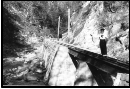
Şekil 68: İnalıtı demiryolu köprüsü.
