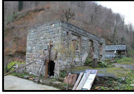
Şekil 73: Burtu bölgesi kullanılmayan işletme binaları.
