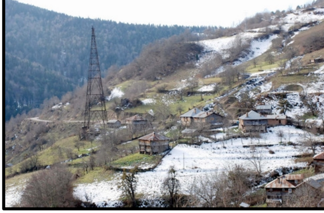
Şekil 38: Çangal bölgesi sistemden geriye kalan tek havai hat direği.
