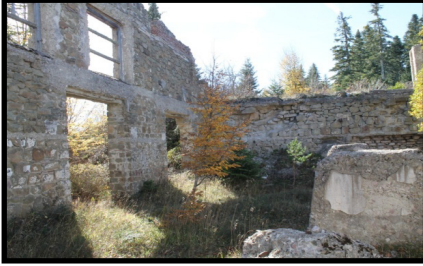
Şekil 36: Çölmektepe istasyonu güç üretim binasına ait kalıntılar.
