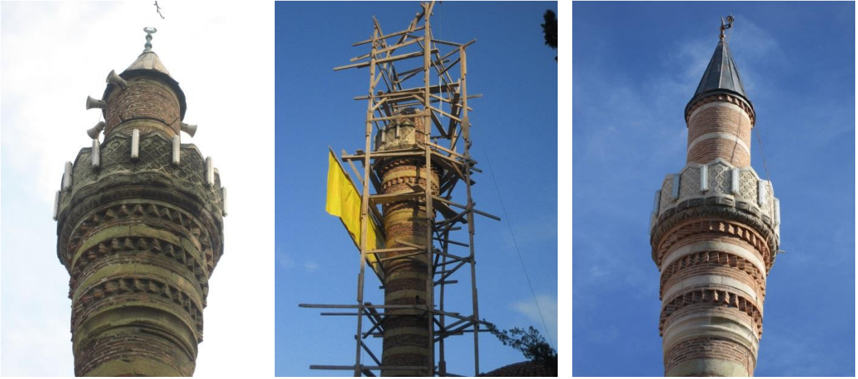
Şekil 6. Trabzon İskenderpaşa Camii minaresinin onarım öncesi ve sonrasına ait bazı resimler.
