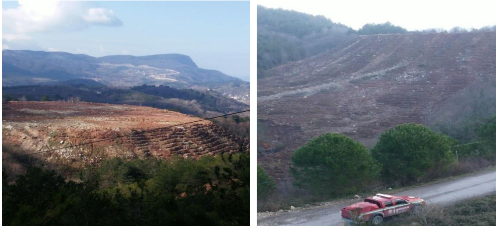
Şekil 4. Teras çalışması yapılan bir rehabilitasyon sahası
