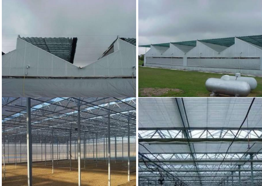
Şekil 2. Gölgeleme perdelerinin sera dış ve iç ortamına yerleştirilmesine ilişkin bir örnek Figure 2. A sample for installation of shading nets to inside and outside of greenhouses
