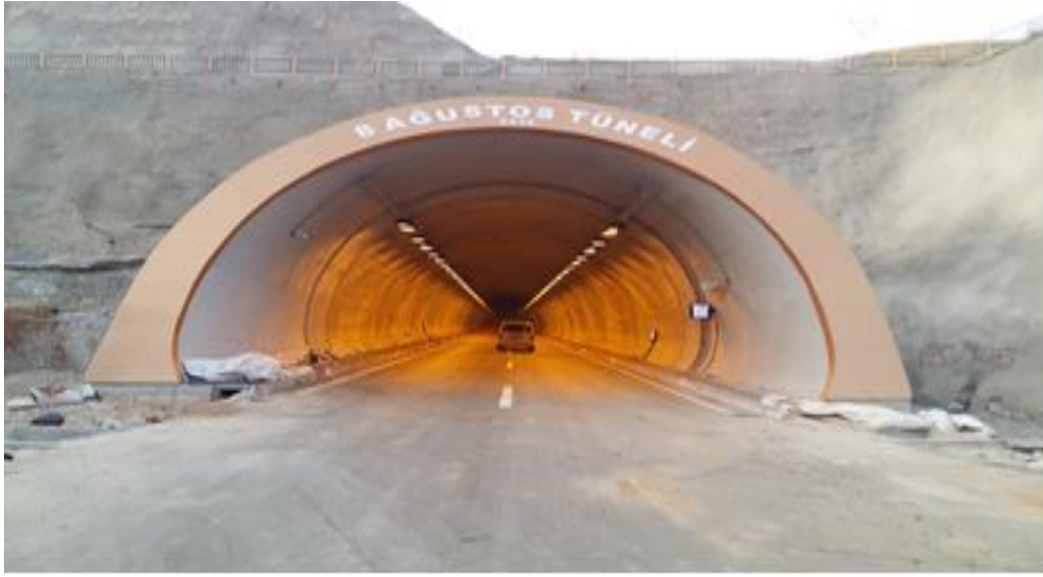
Şekil 3. Sodyum Buharlı Armatürlerle Tünel Aydınlatması
