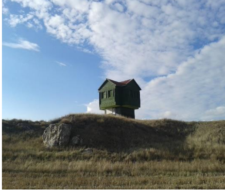
Foto 3: Çimenyenice Kuş Gözlem Kulesi
