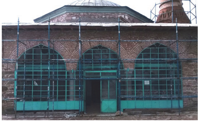
Fot. 6: Son cemaat yeri, eklentiler kaldırılmadan önce ve sonra.
