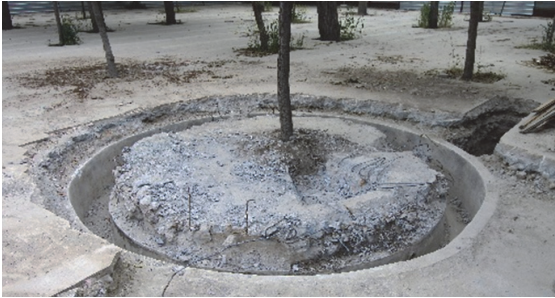
Fot. 18: Avluda ortaya çıkarılan havuza ait kalıntılar.
