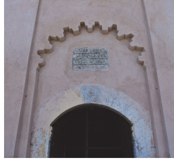
Fot. 35: Gölmarina Şahuban Camii giriş açıklığı.
