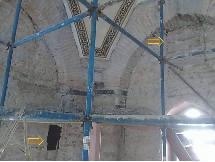
Fot. 23: Son cemaat yerine açılan pencerelere ve özgün minare girişine ait izler.
