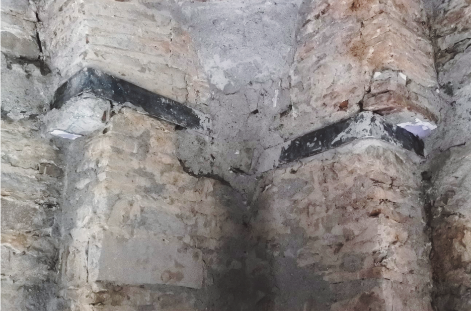
Fot. 28: Duvar içlerine yerleştirilen metal hatıl.
