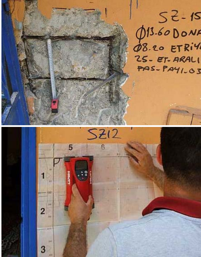
Şekil 7 : Tahribatlı(sıyırma) ve tahribatsız(röntgen) yöntem ile donatı tespiti işlemi
